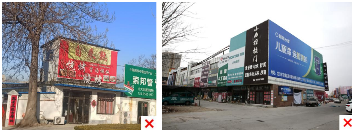
图 3.5.1 危房、危及建筑物使用安全
